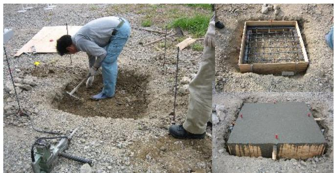
百葉箱 設置工事 電動ピックによる掘削
